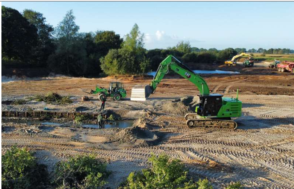
Baustellen mit umfangreichen Erdbewegungen wird die Poske Gruppe zukünftig mit Unterstützung der Software ISL-Baustellenmanager realisieren. | Foto: Poske Gruppe
