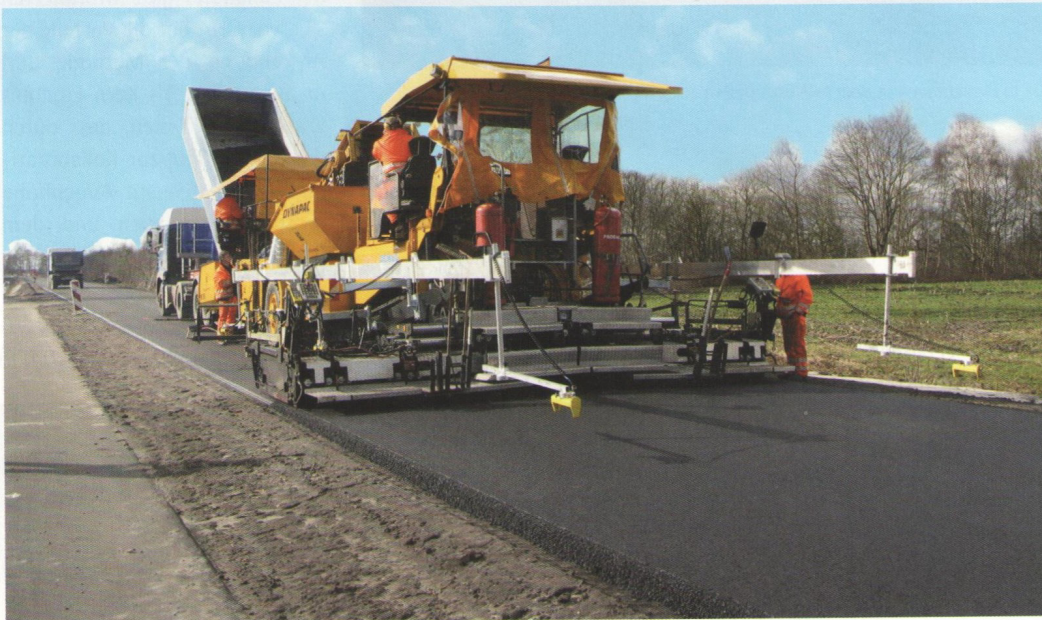
Hoher Grad der Ebenheit ohne Leitdrähte dank Big Sonic-Ski von MOBA, hier beidseitig am Fertiger angebracht (Foto: MOBA)
